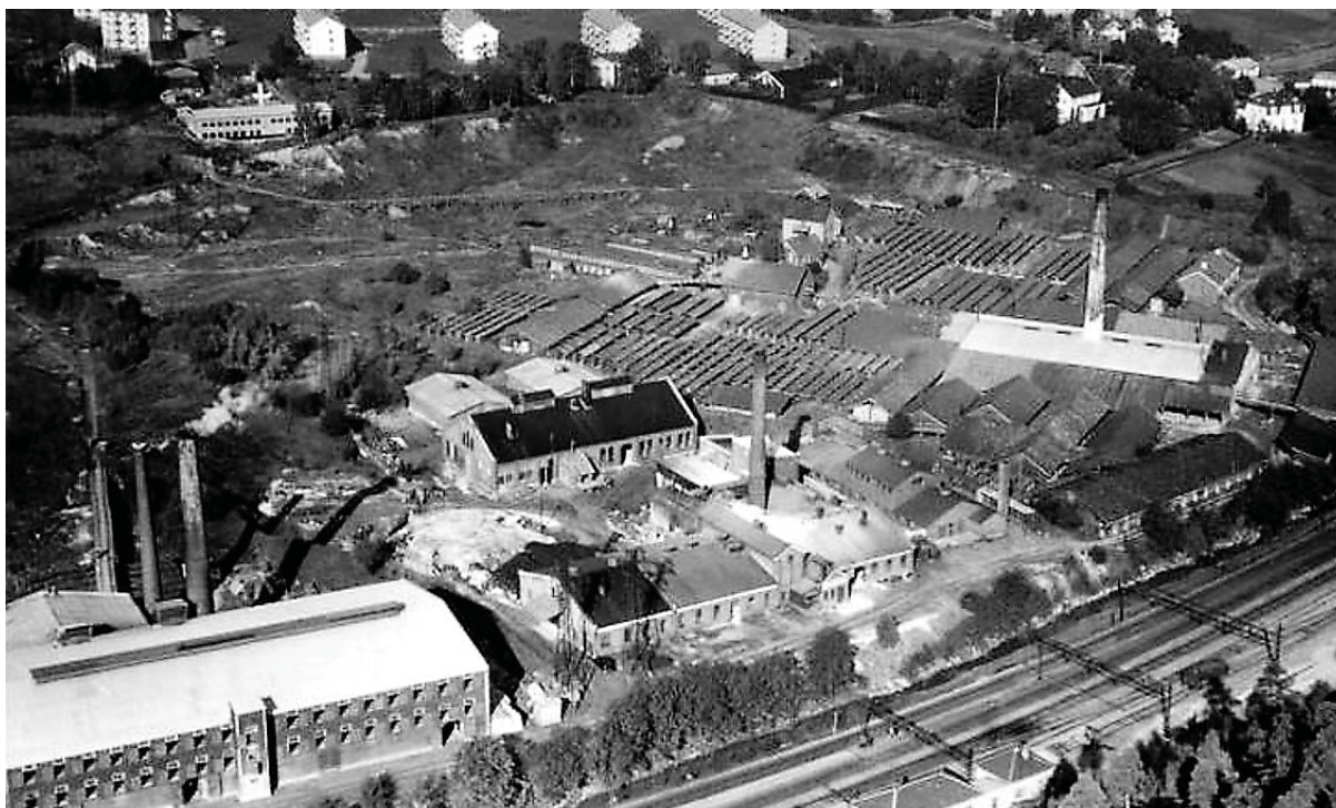
Bak leirgravene ses Teisen Park borettslag og øverst til høyre ligger Bryn skole. Tørkeloftet i nederste venstre hjørne. Widerøes flyveseskap/Otto Hansen, 1951.
