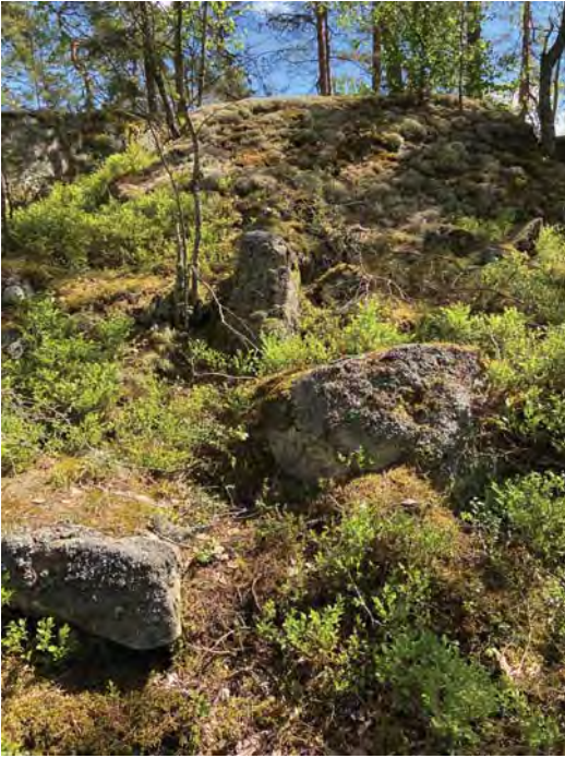
På vestsiden er det stein som har rast nedover skråningen.
