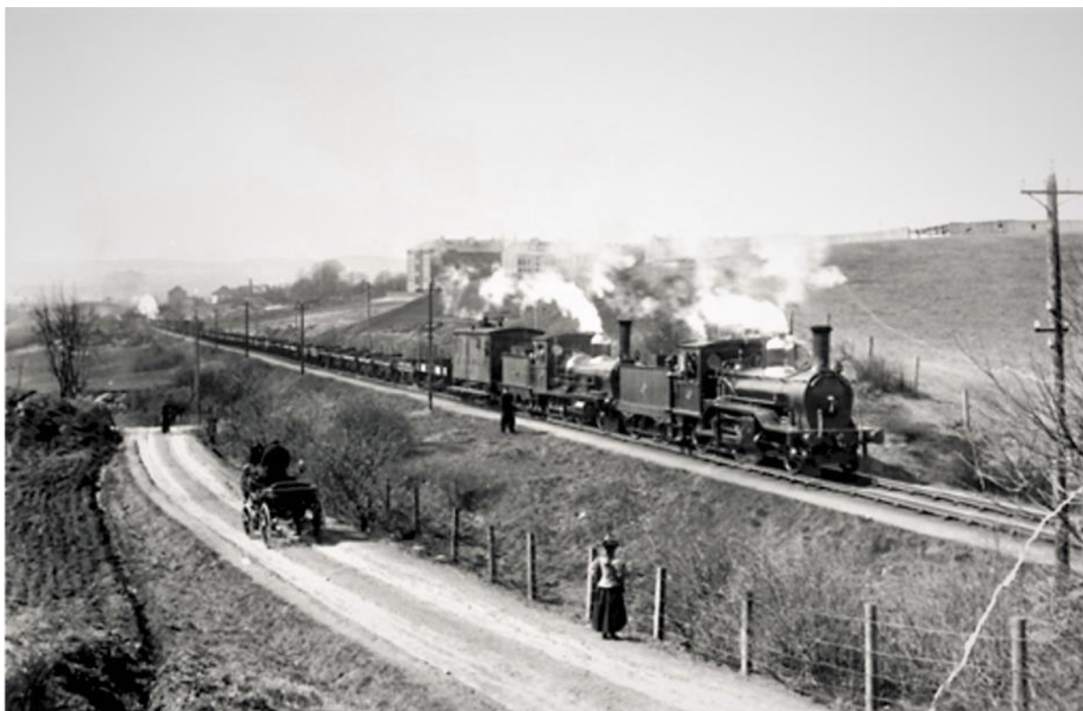
1897 - To damplokomotiv foran et godstog med en rekke tomme trelastvogner i Brynsbakken; toget har også lokomotiver bak
