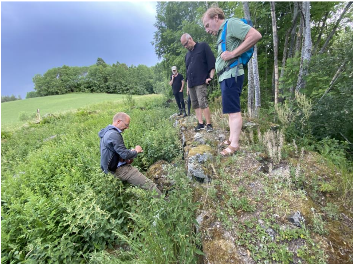
Spesialist på middelalderkirker og kirkearkitektur Morten Stige på leting etter kalkmørtel mellom fugene i steinmuren til brenneriruinene. Professor Frode Iversen fra Kulturhistorisk museum følger godt med. Nærmest kamera Frode Ciljan Jakobsen fra Østensjø historielag og bakerst på muren Amund Kveim fra Østensjøvannets Venner. Foto: Leif-Dan Birkemoe, 16.06.2020.
