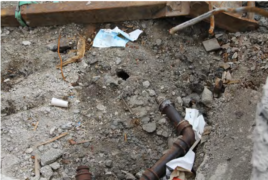
Under arbeidet med å bygge ny kulvert dukket det opp gamle kloakkrør med direkte utløp i Østensjøbekken. Foto: Leif-Dan Birkemoe, 30. juni 2011.
