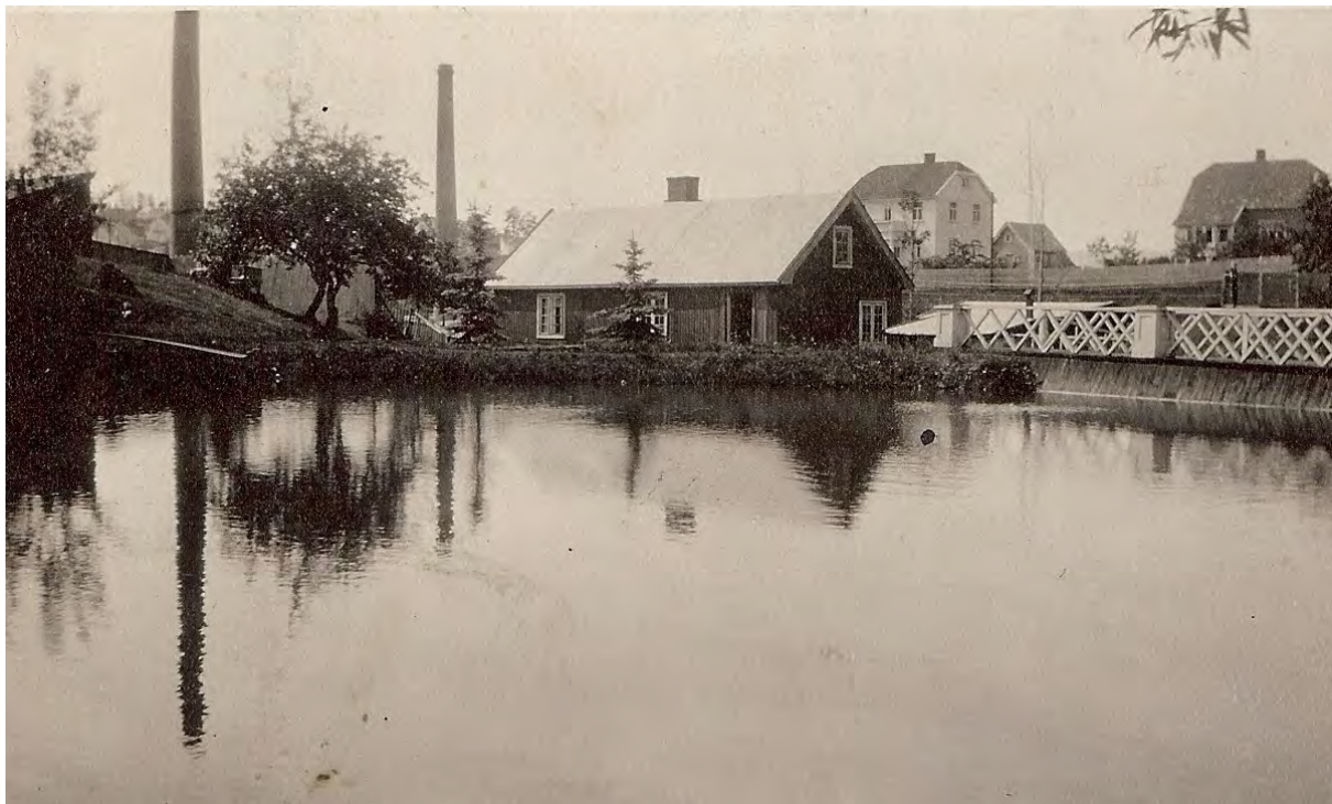
Mølledammen, foto ca. 1930, har navn etter den første bruken, nemlig som kraftkilde til brisselmøllen til P.W.W. Kildal fra 1850-årene. Skorsteinene tilhører Høyenhall Teglverk og Høyenhall Fabrikker. Dammen er velfylt og vesentlig større enn i dag. Kilde: Østensjø lokalhistoriske bilder, bilde-nr. B20100090
