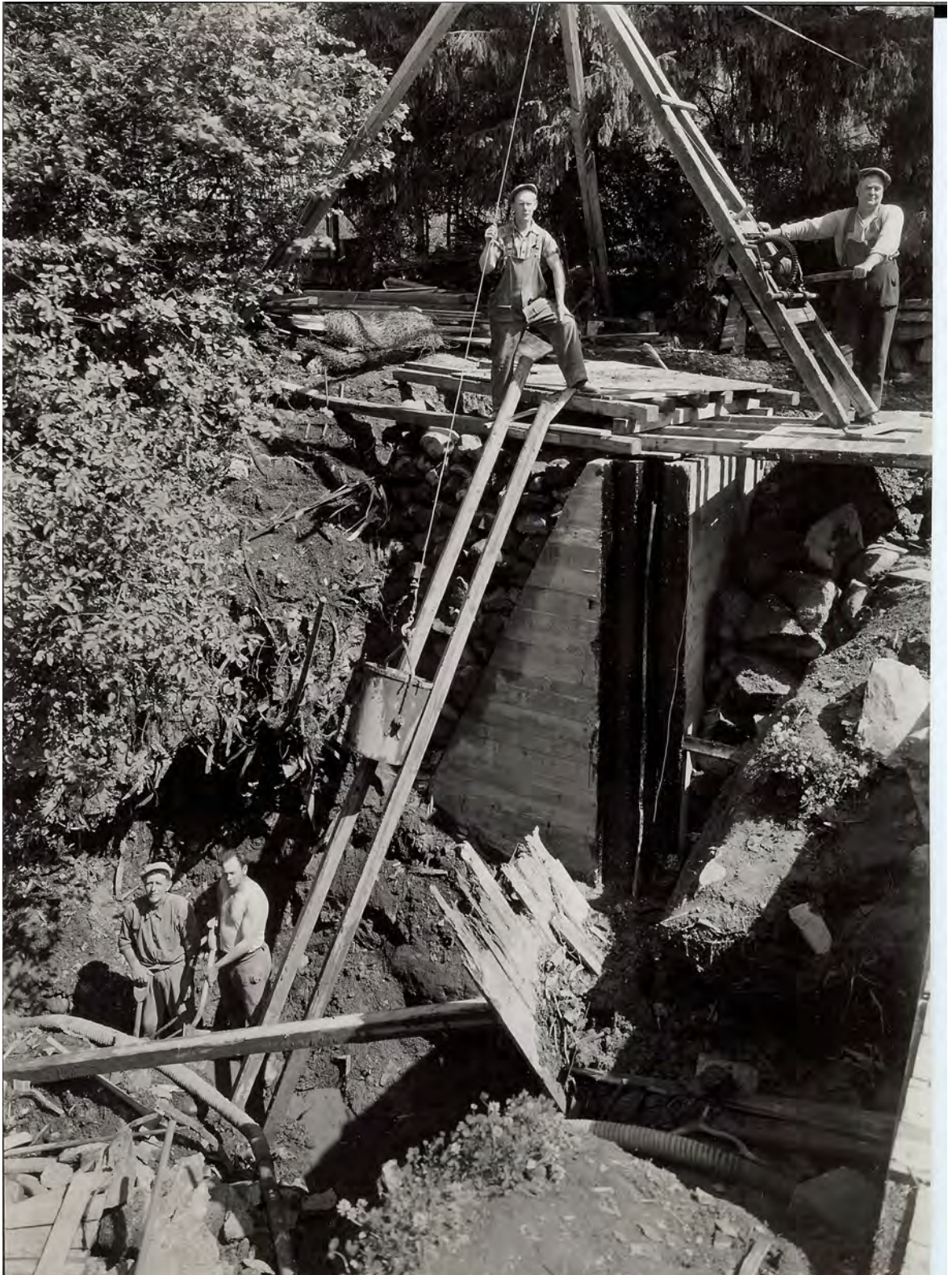
I 1946 ble demningen fornyet og broen over damkronen rehabilitert. Vi ser folk fra entreprenøren Astrup & Aubert A/S i arbeid med støpning. Kilde: Østensjø lokalhistoriske bilder, bilde-nr. B20100095.
