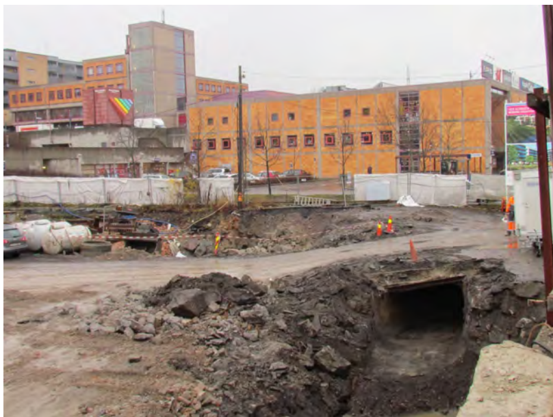
Den gamle kulverten sees tydelig under Harry Fetts vei. Dette er også trolig del av den opprinnelige bekketrasé. Foto: Leif-Dan Birkemoe, 4. november 2011.
