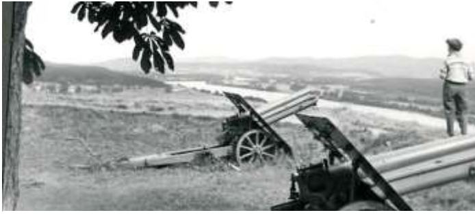
Kongsvinger festning. Oberst Peter Jacob Wilster var sjef for Kongsvingers artillerikompani i 1698. I tiden som inspektør over festningsarbeidet var han her også på besøk. Glomma flyter rolig og dannet en tydelig barrikade mot øst som ble ytterligere forsterket da festningen ble opprettet i 1682. Foto: Leif-Dan Birkemoe, 8. august 1957.
