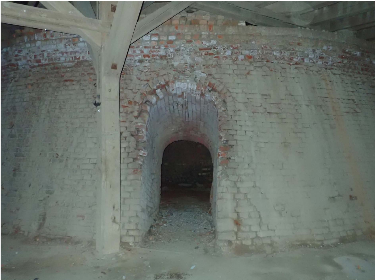
Ringovnen er trolig ett av de flotteste kulturminnene sør i Groruddalen. Østensjø historielag, 2019.
