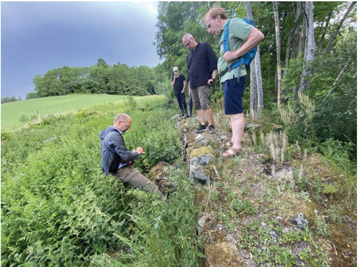
Spesialist på middelalderkirker og kirkearkitektur Morten Stige på leting etter kalkmørtel mellom fugene i steinmuren til brenneriruinen. Professor Frode Iversen fra Kulturhistorisk museum følger godt med. Nærmest kamera Frode Ciljan Jakobsen fra Østensjø historielag og bakerst på muren Amund Kveim fra Østensjøvannets Venner. Foto: Leif-Dan Birkemoe, 16.06.2020.
