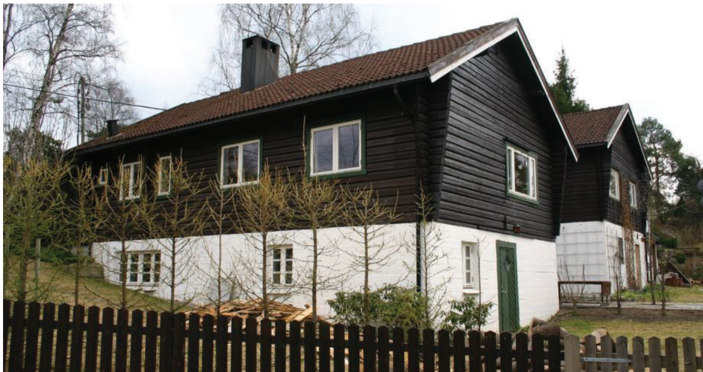
Haakon Tveters vei 29 står nå like støtt på høy grunnmur som da huset ble reist i 1943 og gjorde tjeneste som offisersmesse og velferdsbygg. Foto: Leif-Dan Birkemoe, 19.04.2004.
