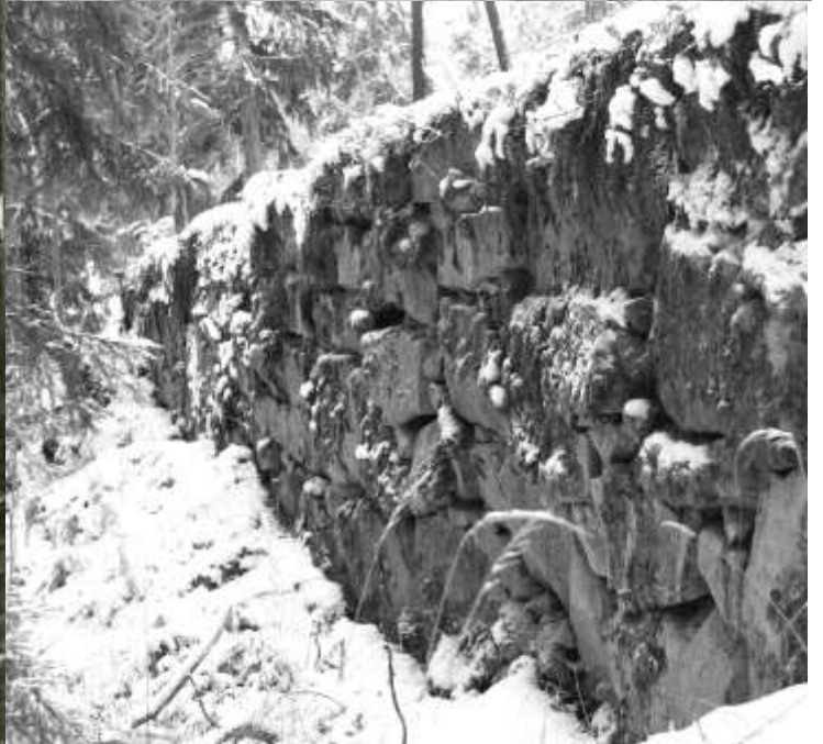
Forsatt kan vi beundre tørrmuren som støtter veien opp fra Ulsrudvann. Den er trolig fra 1856.
