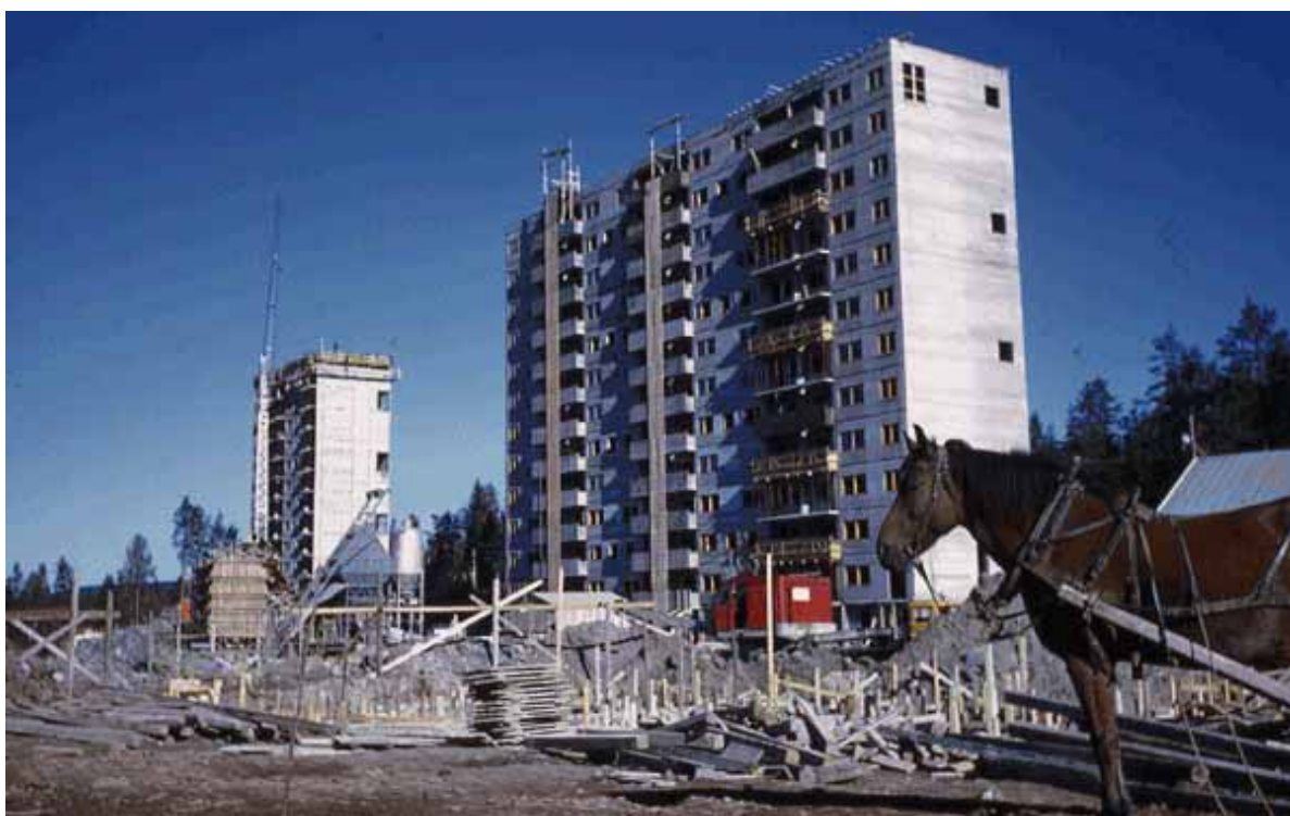
Ny tid møter gammel: Høyblokk under oppføring på Bøler i 1955.
