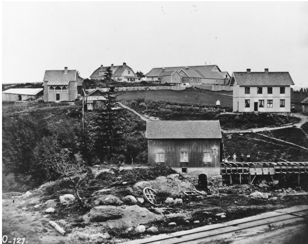
Bryn Mølle i 1860-årene. Bildet er tatt fra Alna og opp mot Brynseng. Ved våningshuset på Bryn gård ligger i dag inngangen til Brynseng holdeplass. Foto: Oslo bymuseum
