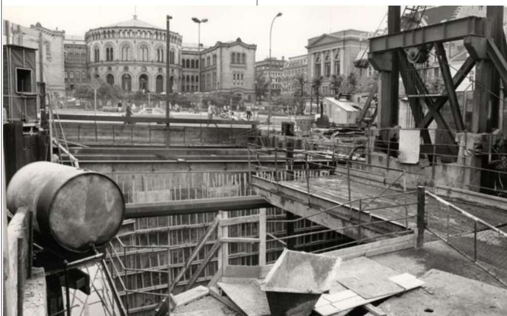
Anleggsarbeidene til T-banen og NSB satte lenge sitt preg på Oslo sentrum
