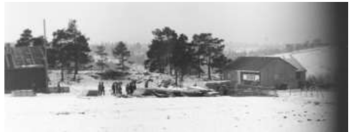
To småhus sør for kommandantboligen, Haakon Tveters vei 35, under oppføring 4. februar 1944. Foto: Cato Hermansen, Østensjø lokalhistoriske bilder, nr. B20130114
