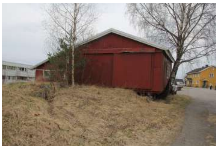
Den tyskbyggete rødmalte «Melbua» har skyvedør over hele den ene vegg på nordsiden slik at motorsykler med sidevogn kunne kjøre rett inn. En oppbygd tilførselsvei fører inn til bua som var godt isolert. Etter krigen ble benyttet som lager for mel. Derav navnet. Foto: Leif-Dan Birkemoe, 08.05.2013. Østensjø lokalhistoriske bilder, nr. B20140222
