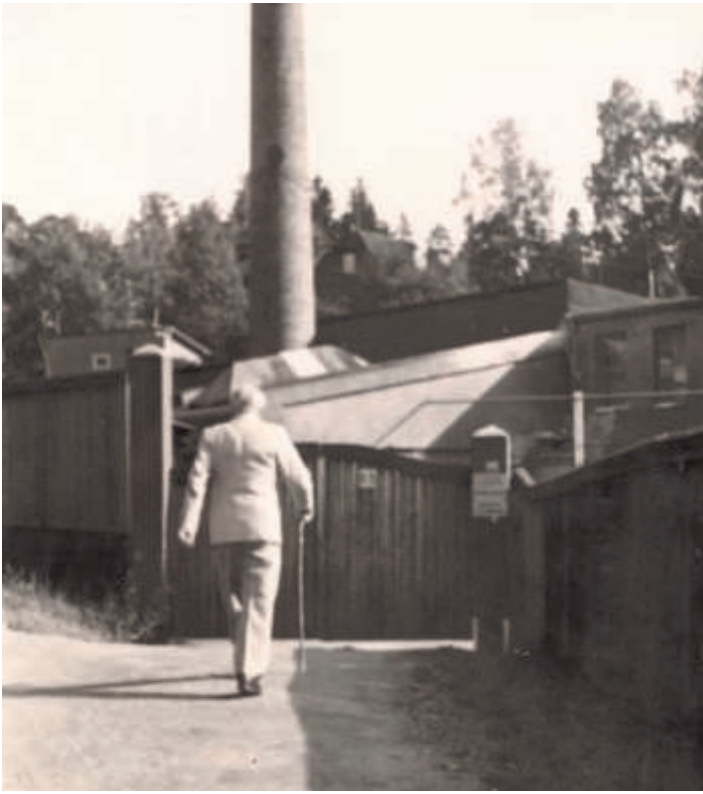
Under 2. verdenskrig var Høyenhall fabrikk et sentralt sted for flyktningtransport til Sverige. Her er Harry Fett på vei til fabrikk i 1943. Kilde: Østensjø lokalhistoriske bilder.
